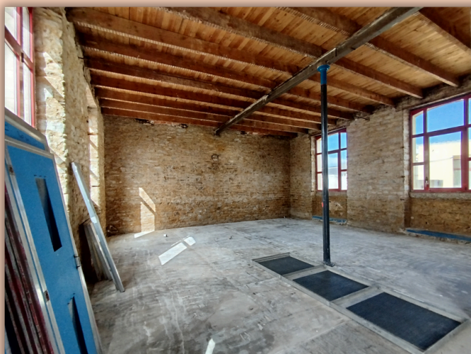
Début des travaux dans le bâtiment primaire de l'École
